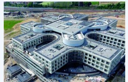
Brussel, België CHIREC - ziekenhuis site Delta (2016) insulit - 100.000 m 2
