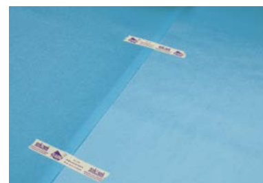
(2) Het behoud van de overlapping verzekeren door bijgevoegde tape
